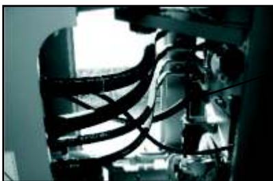
Boca de medidas de presión
